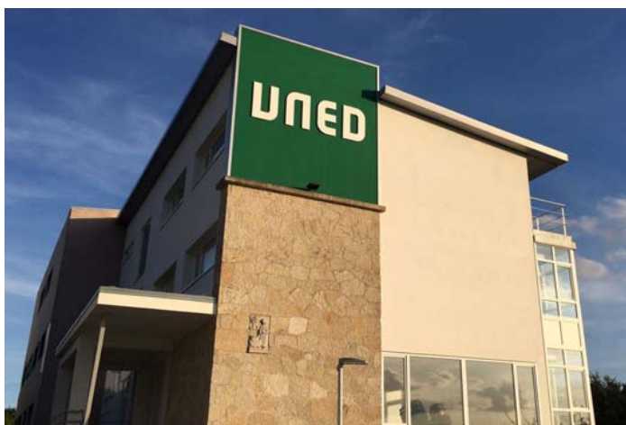
Edificio Hotel Miño (Sede UNED Lugo)
