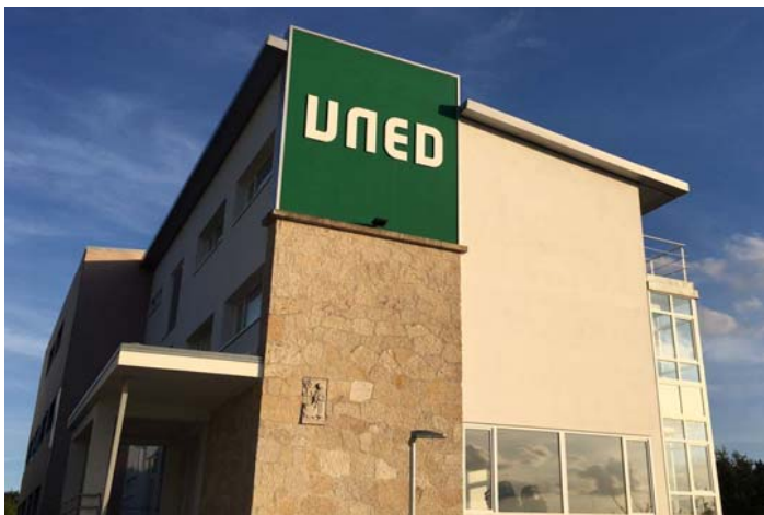
Edificio Hotel Miño (Sede UNED Lugo)
