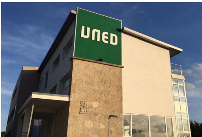
Edificio Hotel Miño (Sede UNED Lugo)
