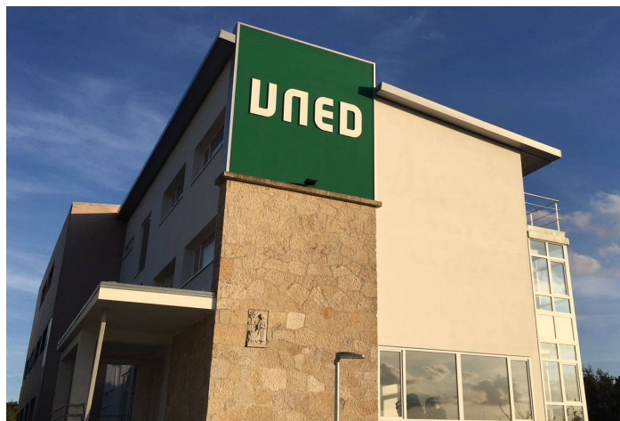
Edificio Hotel Miño (Sede UNED Lugo)
