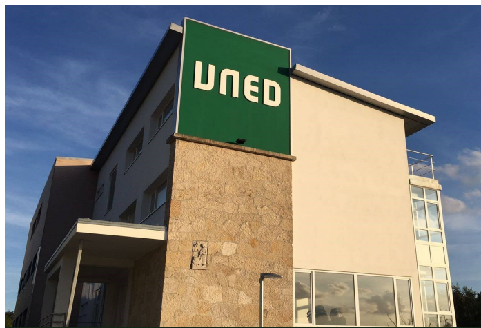
Edificio Hotel Miño (Sede UNED Lugo)
